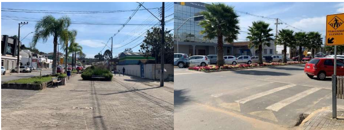
Figura 40 – Trecho de calçada larga | Travessia elevada
