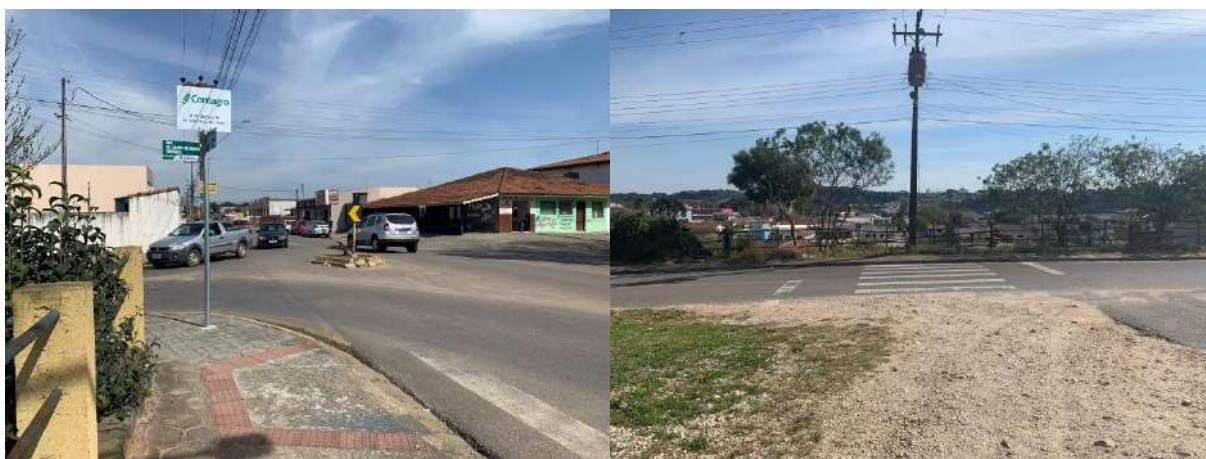
Figura 41 – Esquina com rampa e piso tátil | Faixa de pedestre sem calçada acessível
