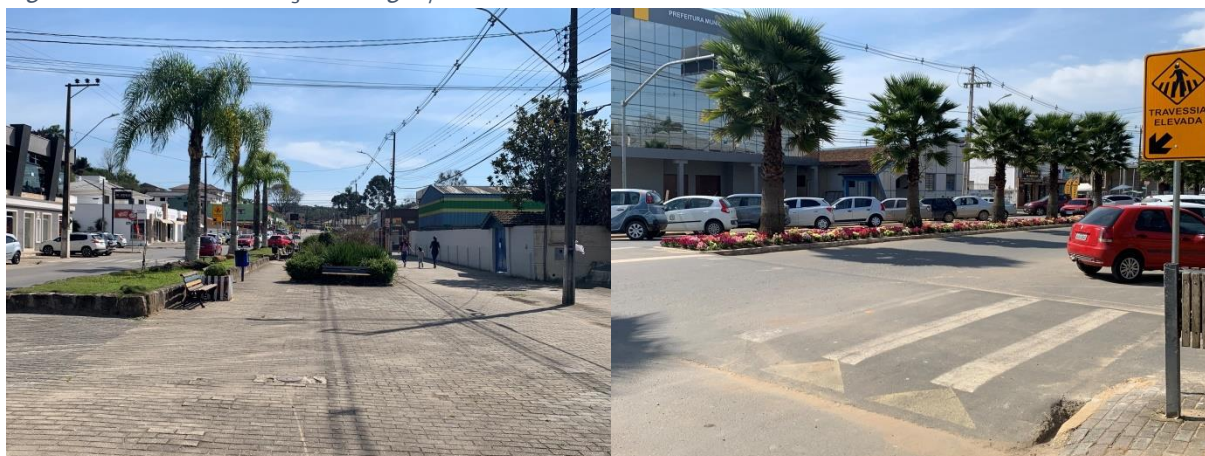
Figura 5 – Trecho de calçada larga | Travessia elevada
