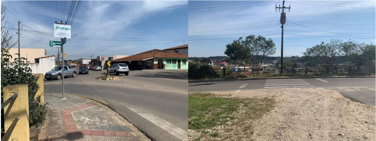
Figura 6 – Esquina com rampa e piso tátil | Faixa de pedestre sem calçada acessível
